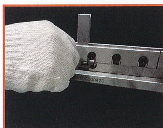
前面ボルト締め付け作業
